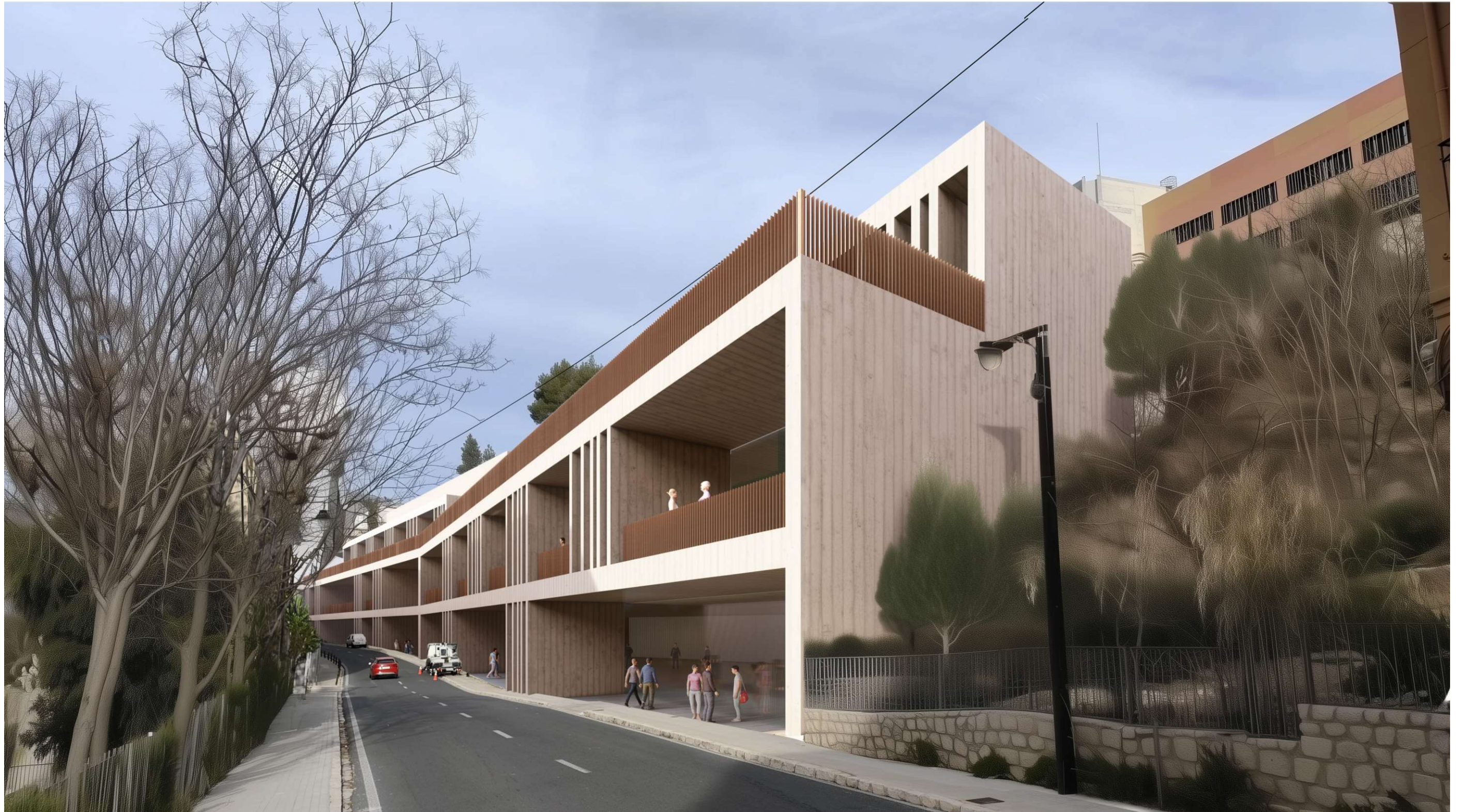
Avda. Alicante, Edificio Beniatá 1. Acceso aparcamiento subterráneo.
